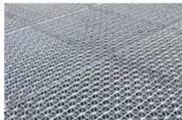
REJILLA METÁLICA ABIERTA
